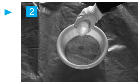
2 充填材と水を混ぜる 硬化が早いため使用する大きさに合わせて必要な分だけを計算して混ぜ合わせて下さい。 (1kgあたり水110cc)
