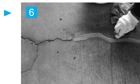
6 ふき取り 充填材が乾かないうちにウエス等で不要部分をふき取して下さい。
