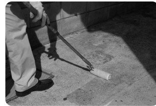
④養生 ⑤ 2 回目塗布
