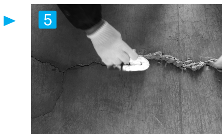
5 均し 金コテを使い充填材を埋め込むように均して下さい。
