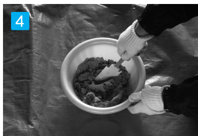
4 攪拌 硬化時間が夏場は最短で約5分(冬場の低温時でも約45分)と短いため速やかに施工して下さい。
