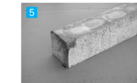
5 仕上げ 充填材の余分は引き取り仕上がり面を金コテを使って整える。
