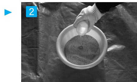
2 充填材と水を混ぜる 硬化が早いため使用する大きさに合わせて必要な分だけを計量して混ぜ合わせて下さい。 (1kgあたり水110cc)
