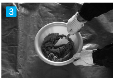
3 攪拌 硬化時間が夏場は最短で約5分(冬場の低温時でも約45分)と短いため速やかに施工して下さい。
