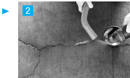
2 補修部分のV字カット 充填材をより密着させるためにサンダーでV字状にカットします。
