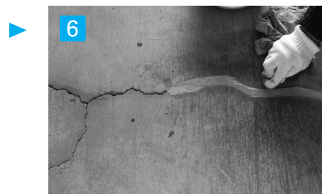
6 ふき取り 充填材が乾かないうちにウエス等で不要部分をふき取して下さい。
