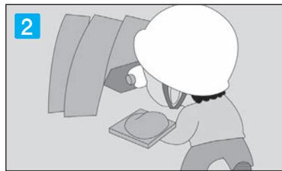
2 躯体に貼り付けエポキシ系接着剤を約5mmの厚さに、30分程度で貼り材を貼ることができる面積に塗ります。
