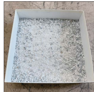
③ 防草サンドや化粧砂利を施工箇所 に投入し、転圧・表面を平滑にし周囲 を養生します。
