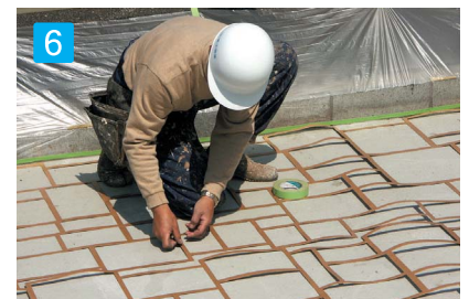
6 ステンシルを固定 下地とステンシルの間にあまり隙間がないようにテープなので固定すると仕上がりがきれいです。
