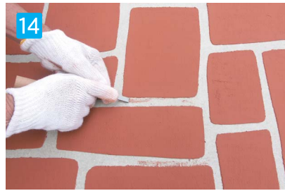
目地部に塗材が付着している場合には除去して下さい。上記の補修はシーラーを塗布してから行った方が除去しやすくなります。
