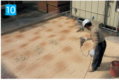
アクセントカラーの吹付け
