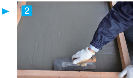
2 コンクリート打設
