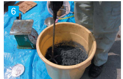
6 攪拌 骨材(ゴムチップ)と流し入れた樹脂を十分に攪拌します。 骨材全体が濡れた感じになるくらいが目安です。 (約10分程度) ※攪拌が不十分ですと、施工不良の原因となります。
