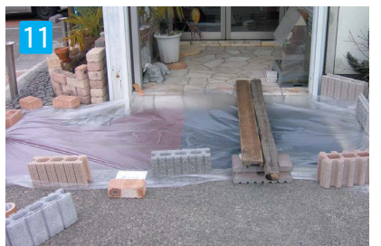
11 養生 硬化するまで養生して下さい。 (降雨、ゴミ、ホコリの付着防止) ※ゴムチップ舗装が歩行可能になるまでに必要な硬化時間は約6時間(外気温25℃条件)です。但し、冬場の外気温5℃以下の場合、約2倍かかることがあります。
