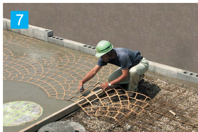
7 ステンシルの端部や不必要な部分をさみ等で切り落とします。
