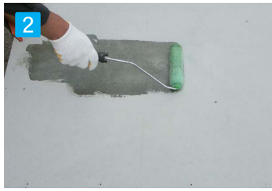
2 プライマー塗布 プライマーが周りに付着しないように必ず養生して下さい。刷毛又はウーローラーで均一に塗布して下さい。
