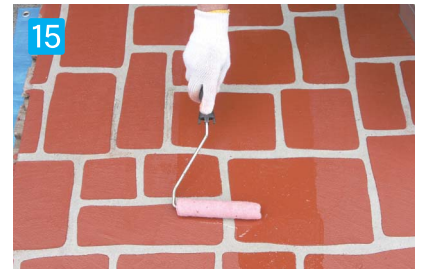
シーラーの塗布 (強度を保持するため、2回塗布をして下さい。)
