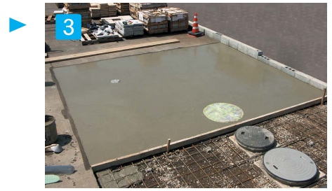
3 生コンクリート仕様の目安 夏場：強度：21以上 スランプ：15～18 冬場：強度：21以上 スランプ：10～12
