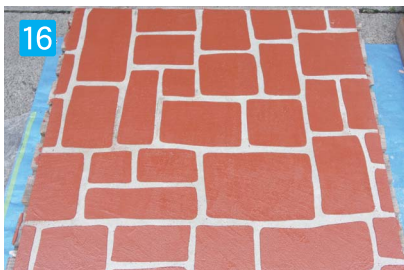
1色使用施工完了。
