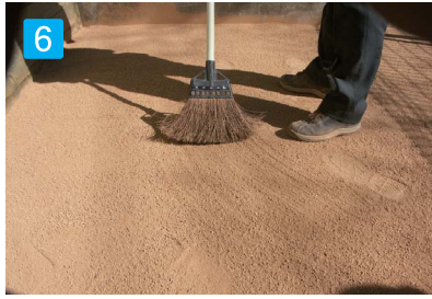
8 コテむらを無くすため、ほうきや剛毛等で表面を均して下さい。
