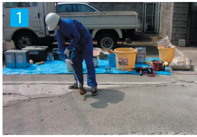
1 下地処理 施工現場清掃作業 ※施工面が平らであることを確認する。(注意1)
