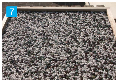
7 ベースの完成 硬化するまで養生して下さい。硬化する前に作業を進めるとベースが動いて施工不良の原因になります。 (硬化までの目安 夏場:6時間以上 冬場:24時間以上)
