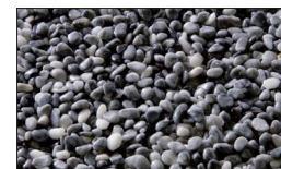
不良施工状態
