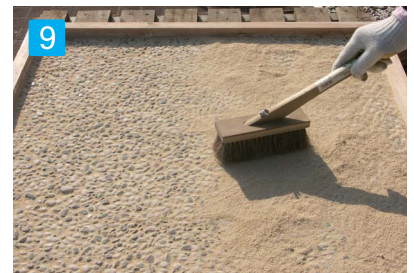
9 余分な充填材を取り除く 石表面がある程度露出する位がきれいな仕上がりになります。
