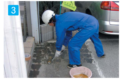
3 プライマーを均一に塗布 小面積用の0.2kgで約1.5m 2 施工出来ます。
