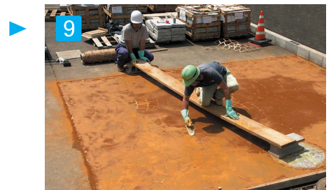
9 この作業を最低2回以上繰り返します。アクセント色を付けない場合は、この作業で色付けは終了となります。 ※均しているときに下地コンクリートが引きずられて見えてこなくなるまで繰り返す。 ※ハードナーの量、コテのあて具合、水分量により表面に様々な表情をつける事が出来ます。
