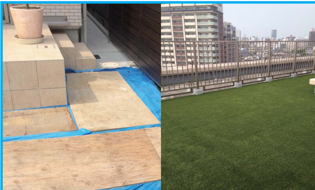
圧着・養生の様子
