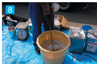
8 混ぜ合わせ 骨材と樹脂を均一に混ぜ合わせて下さい。 ※攪拌不足ですと施工不良(強度のパラツキ)の原因になります。
