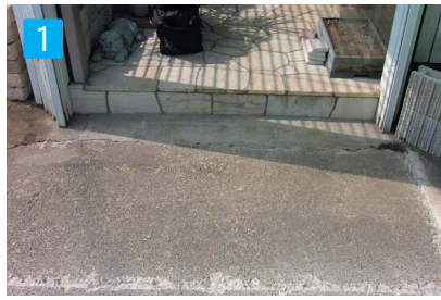
1 下地処理 施工現場清掃作業 ※事前にP21「フローピース施工後の生活臭について」のご注意を必ずご参照下さい。
