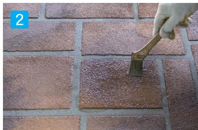
シーラー塗布 白華した部分を除去したら、シーラーを塗布して下さい。 ※シーラー除去剤で白華が取れない場合は市販の白華除去剤をご使用下さい。
