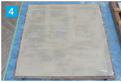
4 乳白色の接着専用プライマーが透明な状態(注意)になってから次工程に進んで下さい。
