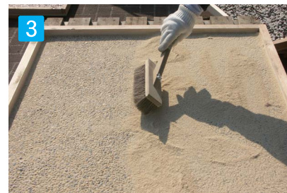
3 余分な充填材を取り除く 石表面がある程度露出する位がきれいな仕上がりになります。
