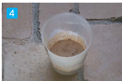
4 補修剤の準備 施工されているカラーと同じ種類のもので補修剤を作ります。 【使用材料】 デックコートステンシル用パウダー デックコートステンシル用レジン 施工されている現状の色調に合うようにレジン进行調合して下さい。 アートクリートステンシル用のハードナーは、接着剤の含有量が少なく、補修用に不向きなため使用しないで下さい。
