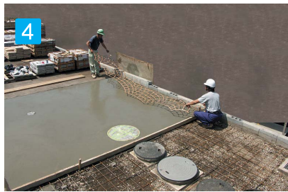
4 ステンシル(型紙)の貼り付け ステンシルのサイド部分と施工範囲の区切り目とを合わせコンクリート面に貼り付けます。
