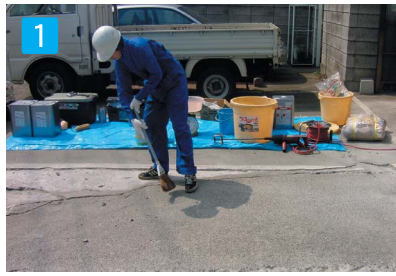
1 下地処理 施工現場の清掃
