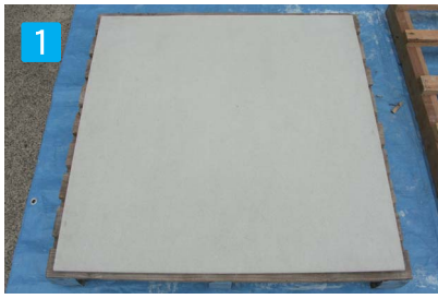
1 下地処理: 施工現場清掃作業。
