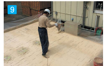
9 ペースカラーの吹きつけ 吹き付け(パウダー1袋、レジン4ℓ)施工面積は約9.3m 2 です。 吹き付け作業は、基本的に下塗りとし仕上げ塗りの2工程です。 ※施工方法により差が生じます。
