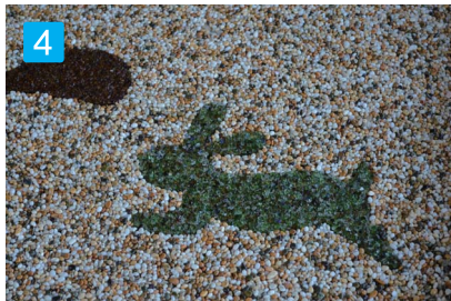
4 フローピースを施工する (フローピース施工要領を参照) ※周囲にフローピースを隙間なく施工します。
