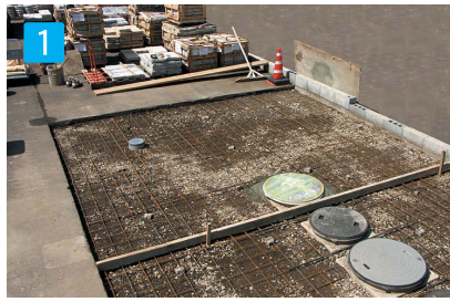
1 土間コンクリートの打設 コンクリート打設前に配筋を行います。
