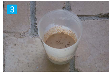
3 補修剤の準備 施工されているカラーと同じ種類のもので補修剤を作ります。 【使用材料】 デックコートステンシル用パウダー デックコートステンシル用レジン 施工されている現状の色調に合うようにレジン进行調合して下さい。 アートクリートステンシル用のハードナーは、接着剤の含有量が少なく、補修用に不向きなため使用しないで下さい。
