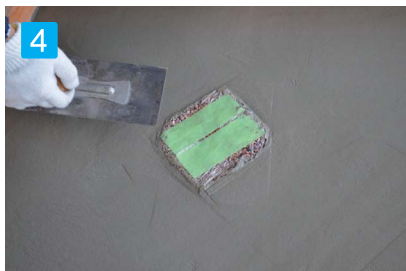
4 コンクリートを均す
