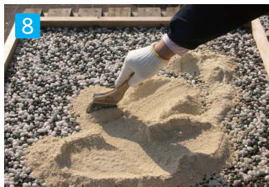
8 充填材の投入 充填材(粉末)を適量配り刷毛やブラシで石目の間や隙間に充填しながら均一に敷き均して下さい。
