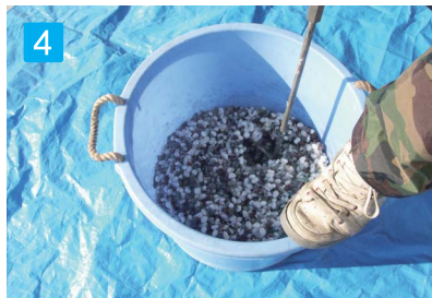
4 攪拌 骨材の表面全体に樹脂が付着するまで十分攪拌して下さい。
