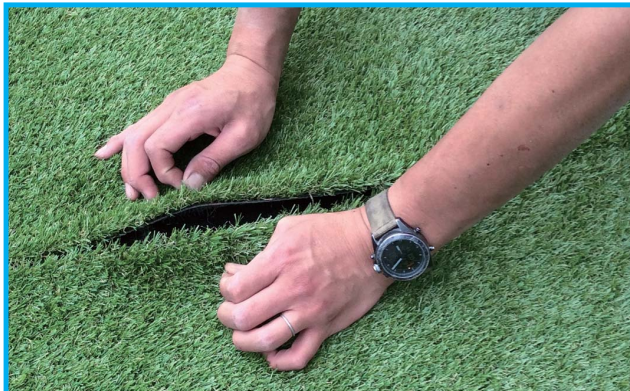
継目を調整し、貼り合わせている様子
