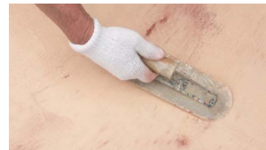
アクセントカラーを塗布したら金コテで軽く押えて下さい。
