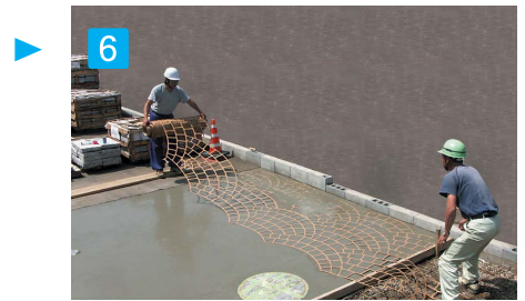
6 2列目のステンシルを貼り付けるときは、前に貼り付けたステンシルの端部と2列目のステンシル端部が重なり合うように貼り付け、同じようにコテで均します。
