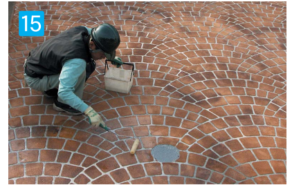
15 シーラーの塗布 (強度を保持するため、2回塗布をして下さい。) 施工後2~3日養生し、シーラーを刷毛、もしくはローラーにて塗布して下さい。 ※シーラーは塗布後(晴天の状態)6時間以上養生して下さい。
