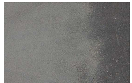
砂を均した状態
