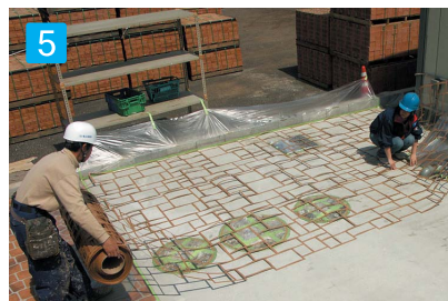
5 2列目のステンシルを設置するときは、前に設置したステンシルの端部と2列目のステンシル端部が重なり合うように設置して下さい。
