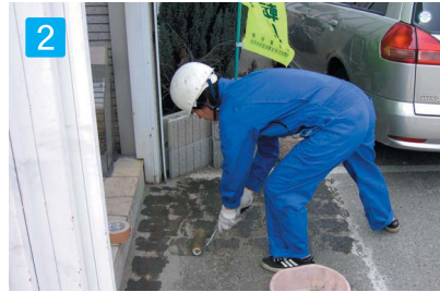
2 施工下地にプライマーを塗布 プライマーの塗付可能面積の目安 ウールローラー:約150g/m 2 刷毛:約100g/m 2 (使用する塗付工具により異なります)
