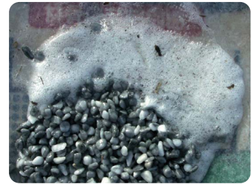
均し作業における注意事項 樹脂溜まりが来ると、写真のように発泡状態となります。樹脂溜まりがある場合は、まわりの骨材とよく混ぜ合わせて下さい。
