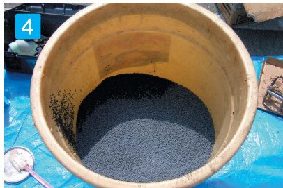
4 骨材投入 骨材(ゴムチップ)をポリ容器に投入します。
