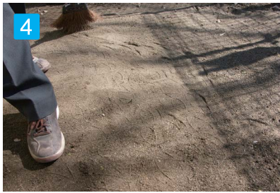
4 転圧。(踏み固める。) 端部はブロック等で固定し、境界部の抑えをしっかり行って下さい。
