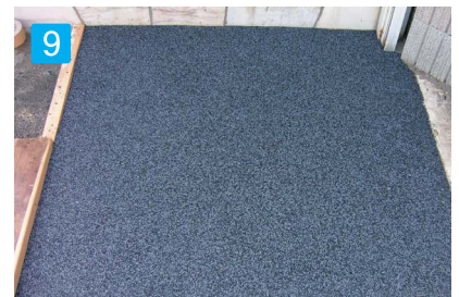
9 均し完了 施工現場の清掃
