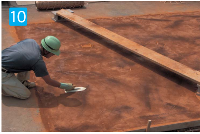
10 アクセントカラーの施工 ベース色の上からアクセント部分のカラーハードナーを任意の量振りかけ、軽く均してからカラーハードナーをなじませます。
