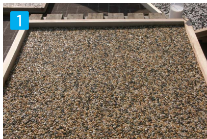
1 下地処理 施工現場(フローピースレギュラー)の清掃 ※フローピースレギュラーを施工の際にノンスリップ材の使用はお避け下さい。
