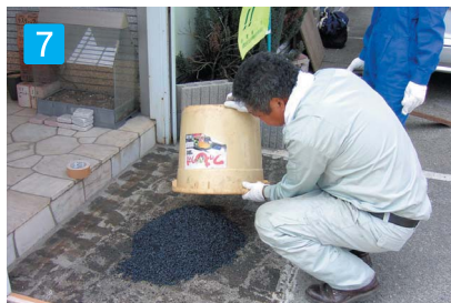
7 均し作業 骨材を施工箇所へ移します。
