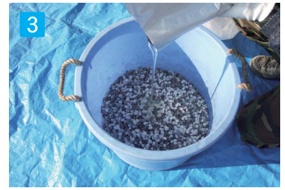
3 骨材と樹脂混合 容器に骨材を投入し専用樹脂を全量流し込んで下さい。
