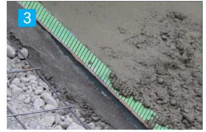
3 タイルを専用テープ養生し、土間を打つ。 ※タイル面に合わせて、土間を施工して下さい。
