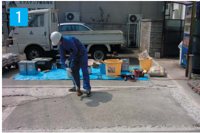
1 下地処理 施工現場清掃作業
