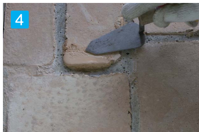
4 コテ仕上げ 【仕上げの際に使用するコテの種類】 アートクリートステンシルの場合…金コテで表面を均して下さい。 デックコートステンシルの場合…木コテ・プラスチックで表面を均して下さい。
