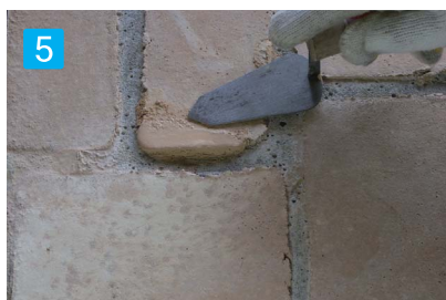
5 コテ仕上げ 【仕上げの際に使用するコテの種類】 アートクリートステンシルの場合…金コテで表面を均して下さい。 デックコートステンシルの場合…木コテ・プラスチックで表面を均して下さい。
