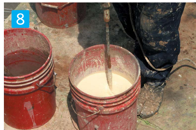
8 クリーム状になるまでよく攪拌 状況により、粘度の調整には水を少量使用して下さい。
