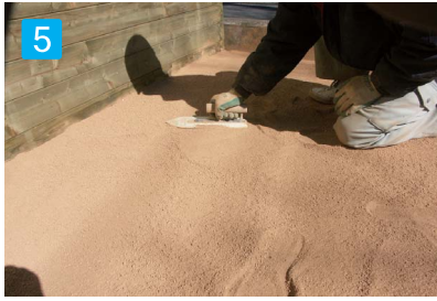
7 ウィーガード／ウィーガード御影を敷き均す。飛散した材料が付着しないように周辺を養生して下さい。木コテ・プラスチックコテで均し押さえて下さい。(平らに整地する程度、押さえすぎると施工厚が40mm以下となり、透水性・保水性が低下します。)
