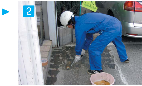
2 施工下地にプライマー(1液性)を塗布
