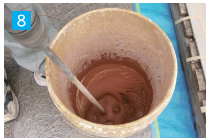
8 パウダーと専用混和剤を攪拌機でよく混ぜ合わせて下さい。
