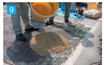
9 均し作業 施工場所に骨材を流し込みます。
