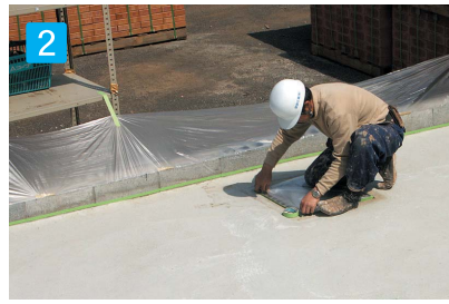
2 施工場所を養生
