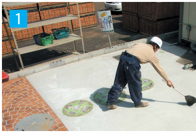
1 下地処理 施工現場清掃作業
