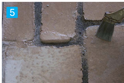
5 シーラー塗布 欠け部分の補修が完了したら、シーラーを塗布して下さい。
