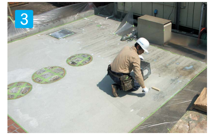
3 下地処理剤の塗布 下地処理剤(純正レジン(40~50g/m 2 ))を水で2~3倍希薄液)塗布。吹付ける合材との接着をよくするために均等に塗布して下さい。
