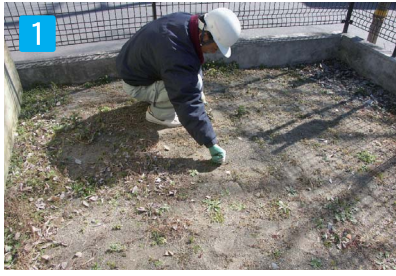
1 施工する場所の除草。
