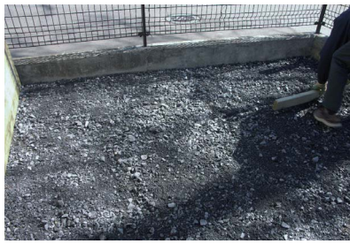
5 砕石を敷き均す。
