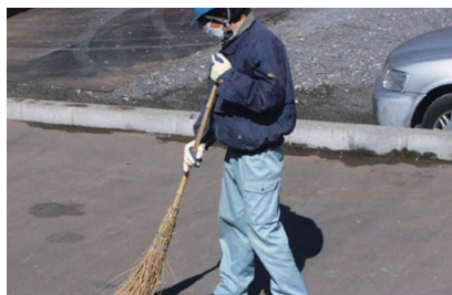
下地処理 施工現場清掃作業
