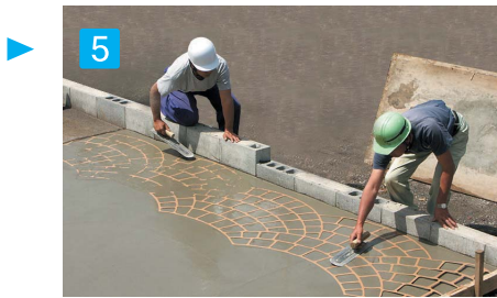
5 貼り付けたステンシルの中央部分から端側に向かって木ゴテもしくはプラスチックコテにてステンシルがややコンクリートにめり込むように均していきます。
