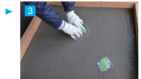
3 デザインピースを埋め込む ※コンクリートがまだ柔らかいうちに埋め込む(注意3)
