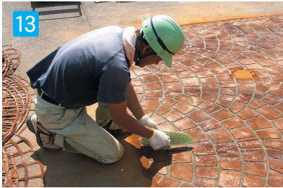
13 バリが出たり、目地にカラーハードナーが染み込んだりしたところは、目地ゴテもしくは木ゴテを使い補修して下さい。
