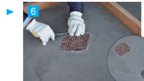
6 完成 硬化した後、ラップを除去する。
