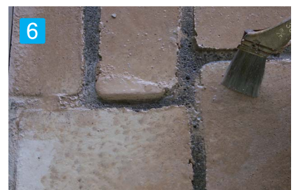
6 シーラー塗布 欠け部分の補修が完了したら、シーラーを塗布して下さい。
