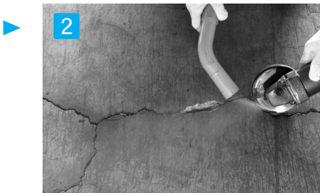
補修部分のV字カット 充填材をより密着させるためにサンダーでV字状にカットします。
