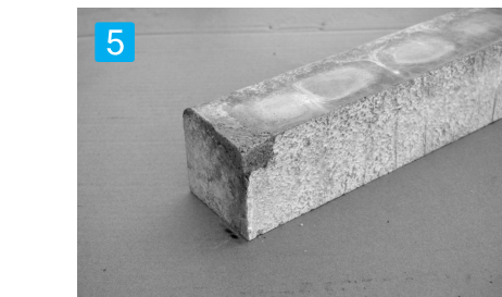
仕上げ 充填材の余分は引き取り仕上がり面を金コテを使って整える。
