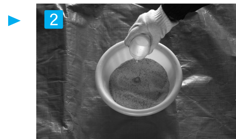
充填材と水を混ぜる 硬化が早いため使用する大きさに合わせて必要な分だけを計量して混ぜ合わせて下さい。 (1kgあたり水110cc)
