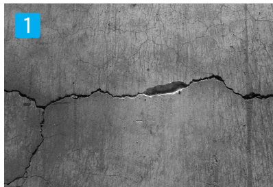
下地処理 施工現場の清掃(ゴミ、油、塗料などをきれいに取り除く)
