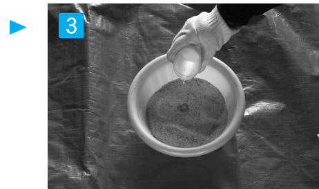
充填材と水を混ぜる 硬化が早いため使用する面積に合せて必要な分だけを計量して混ぜて下さい。(1kgあたり水110cc)
