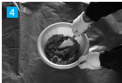
攪拌 硬化時間が夏場は最短で約5分(冬場の低温時でも約45分)と短いので速やかに施工して下さい。
