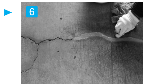
ふき取り 充填材が乾かないうちにウエス等で不要部分をふき取して下さい。
