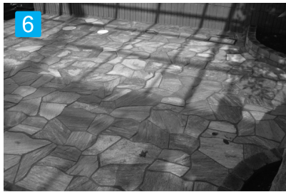
6 拭き取り完了。 * 目地材が硬化していなくても路板を使用すれば、人の歩行が可能です。 * 目地材が硬化すれば、直接に人の立ち入りが可能です。 * 車を乗り入れするには、目地施工完了後最低24時間必要です。
