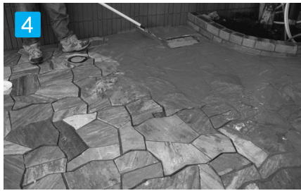
4 クイックストーンの敷き詰めが完了後、表面を清掃し散水してモルタルで目地施工して下さい。 * 目地は強度を保持するためにも、必ず無収縮目地セメントを使用し施工して下さい。 参考品: 菊水化学工業(KSメジ)・太平洋マテリアル(タイロン) * 散水はノズルのシャワーを使用し、目地施工する部分全体を濡れた状態にして下さい。 ただし、水を撒き過ぎないように注意して下さい。 * 散水することによりクイックストーン表面の石材が吸水し、目地用モルタルが附着し難くなるためモルタルが均しやすく、またスポンジで拭き取り易くなります。 * 目地モルタルは、「イナメジ」G2N(灰)・G3N(濃灰)・G4N(黒)などをお薦めします。 目地モルタルの混合比・・・目地材(4~5):水(1)
