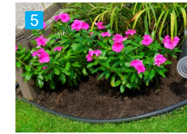
5 土を埋め戻し転圧をかけ設置完了です。
