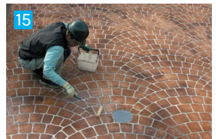
15 シーラーの塗布(2回塗りをお勧めします) 施工後2~3日養生し、シーラーを刷毛、もしくはローラーにて塗布して下さい。 ※シーラーは塗布後(晴天の状態)で6時間以上養生して下さい。
