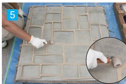
5 ステンシルパターン(コプルストーンN)を市販のプラスチックローラーで十分密着させながら貼りつけて下さい。
