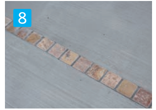
8 テープ養生をはがし、面取り不要で完成です。
