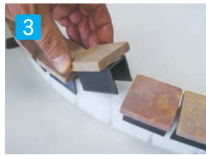
3 Rの曲がり具合によって石を取り外し、目地の広さを調整して下さい。(石部分は仮止めのため、自由に取り外し可能です。)
