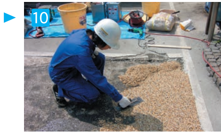
均し仕上げ作業 仕上げは金ゴテを使用し、平滑になるように十分押さえながら同時に施工厚を確認し、仕上げていきます。
