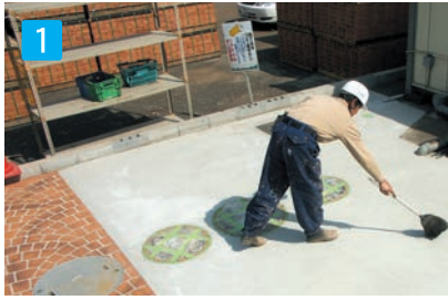
1 下地処理 施工現場清掃作業
