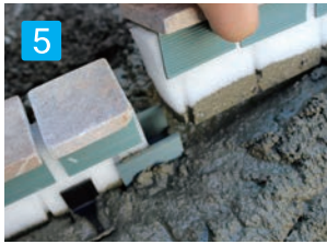
5 つなぎ施工の際はアールタイプに付属している「コ」の字型部材を下にはめ、ジョイントして下さい。
