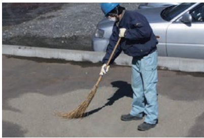
下地に振るい砂を散布し表面が平滑になるようホウキ等で均してください。
