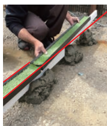
②モルタルを敷きベース材を固定し、水糸に合わせて勾配や傾きを調整する（水糸を2本張って天端を合わせることで、調整がしやすくなります）
