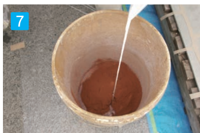
7 パウダー(テラコッタN)に専用混和剤を混合して下さい。
