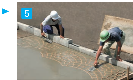
5 貼り付けたステンシルの中央部分から端側に向かって 木コテもしくはプラスチックコテにてステンシルが ややコンクリートにめり込むように均していきます。
