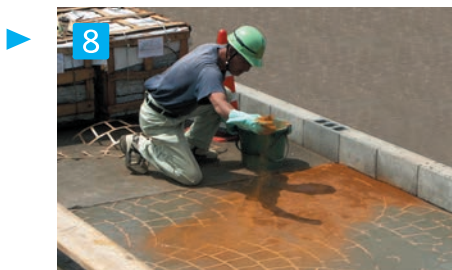
8 ベースの色づけ カラーハードナーのベース色をセメント表面部にまん べんなく振りかけ、ハードナーの色が濃くなるまで 待ち、表面をコテ等で均しコンクリートと馴染ませ ます。 ただし、水分量が少ないとハードナーとの密着が不十分 となり、剥離することがあり、水分量が多すぎると色ムラ や白華が発生し易くなります。
