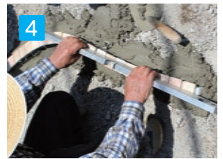
4 商品を置き、水平機で土間面の高さに合わせます。
