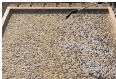
10 吹きつけ(スプレー) 樹脂が付属のスプレーや噴霧器(現地調達)で石の表面を洗い流すように均等に規定量を吹きつけて下さい。
