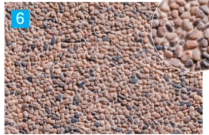
6 ノンスリップ材を撒いた場合の仕上がり 既にフローピースを施工している現場でノンスリップ材が残っている場合、ノンスリップ材に色粉が付着し写真のような仕上がりになります。
