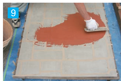
9 1色使用。金コテで薄く塗り込んで下さい。塗り厚は0.5mmが目安です。
