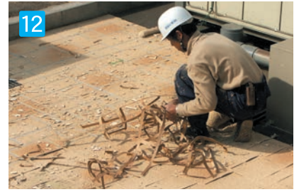
12 ステンシルを除去 塗料が乾いた段階でステンシルを除去します。
