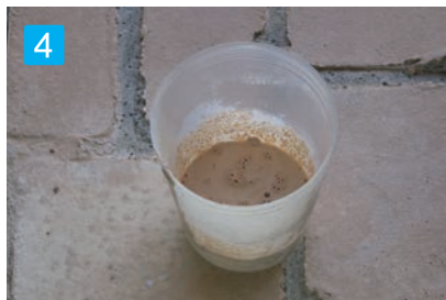
4 補修剤の準備 施工されているカラーと同じ種類のもので補修剤を作ります。 [使用材料] デックコートステンシル用パウダー デックコートステンシル用レジン 施工されている現状の色調に合うようにレジンを調合して下さい。 アートクリートステンシル用のハードナーは、接着剤の含有量が少なく、補修用に不向きなため使用しないで下さい。
