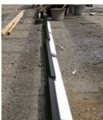
②モルタルを敷きベース材を固定し、水糸に合わせて勾配や傾きを調整する（水糸を2本張って天端を合わせることで、調整がしやすくなります）
