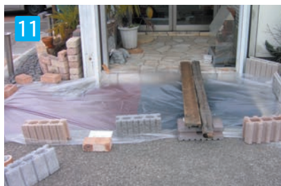
11 養生 硬化するまで養生して下さい。 (降雨、ゴミ、ホコリの付着防止) ※ゴムチップ舗装が歩行可能になるまでに必要な硬化時間は約6時間(外気温25℃条件)です。但し、冬場の外気温5℃以下の場合、約2倍かかることがあります。
