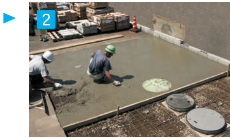
2 土間コンクリートはコテで均し、 表面を平らにしてください。
