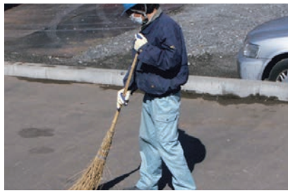
下地処理 施工現場清掃作業
