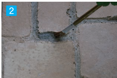
2 レジン塗布 レジンを原液のまま補修部分に塗布して下さい。
