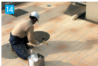
14 シーラーの塗布(2回塗りをお勧めします) 施工後、表面が完全に乾燥したらシーラーを刷毛もしくはローラーにて塗布して下さい。溶剤系のシーラーのため、塗布後はツヤがありますが、1週間くらいで落ち着きます。 ※シーラーの養生期間: シーラー塗布後(晴天時の状態で) 6時間以上養生して下さい。
