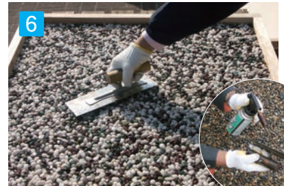
6 敷き均し 金コテを使って平滑になるように十分押さえながら、同時に施工厚を確認しながら均して下さい。 (施工厚:15mm以上) ※バーナーで金コテを熱を加えると滑りがよくなります。
