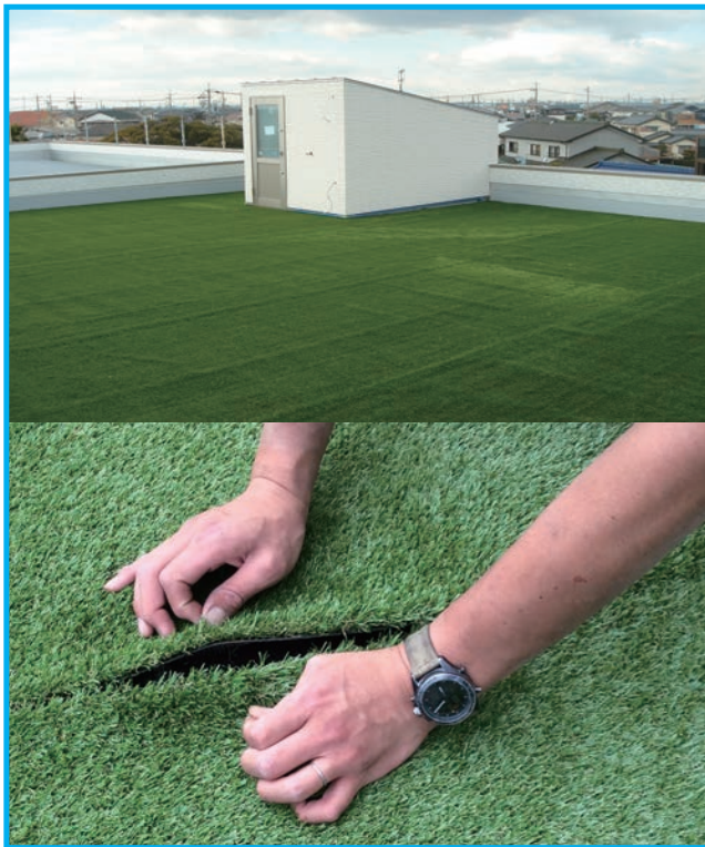
左図：継目を調整し、貼り合わせている様子
