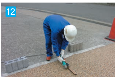
仕上げ作業 大面積の場合、20m 2 ごとに目地きりを入れます。
