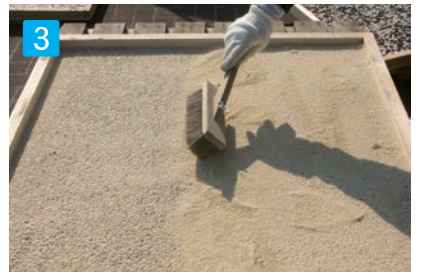
3 余分な充填材を取り除く 石表面がある程度露出する位がきれいな仕上がりになります。
