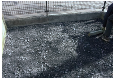
5 砕石を敷き均す。
