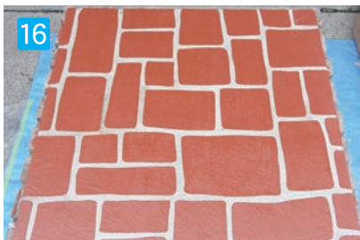
1色使用施工完了。
