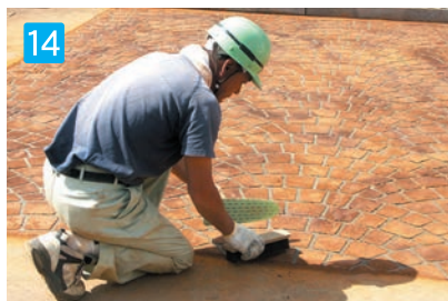
14 補修 補修作業が終わりましたら、柔らかめのブラシ、もしくはフローアー等にて細かなセメントの欠片等を取り去って下さい。完全に硬化してからの除去は困難となります。白華が発生している部分は、ブラシ等で表面をこすり、白華を取って下さい。
