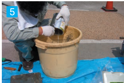
5 樹脂(1液性)投入 容器に樹脂を全量、流し込んで下さい。
