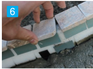
6 ジョイント部分は横スレ防止の為、特にしっかりとモルタルで固定して下さい。
