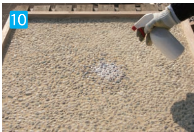
10 吹きつけ(スプレー) 樹脂が付属のスプレーや噴霧器(現地調達)で石の表面を洗い流すように均等に規定量を吹きつけて下さい。
