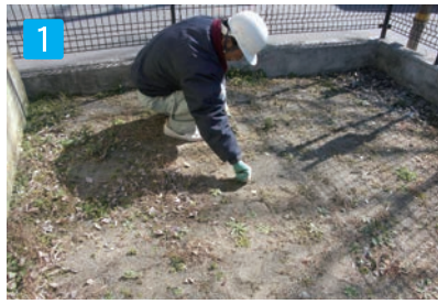
1 施工する場所の除草。
