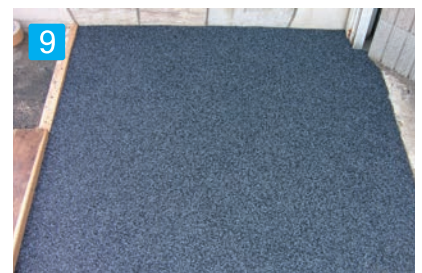
9 均し完了 施工現場の清掃
