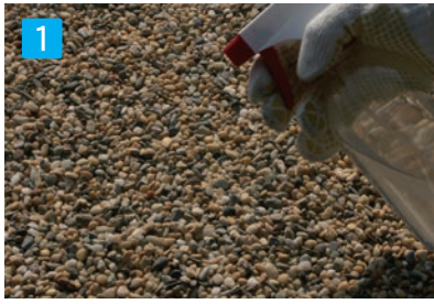
1 回目の噴霧 バインダーを付属のスプレー容器に移し、固定したい砂利の上から均等に適量をスプレーします。
