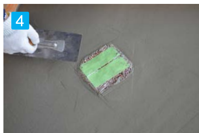
4 コンクリートを均す
