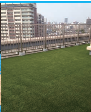
施工完了後の様子
