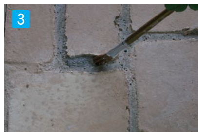
3 レジン塗布 レジンを原液のまま補修部分に塗布して下さい。
