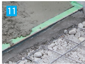
11 石をテープ養生し土間を打ちます。コテで均します。コテで均します。(土間は石の面より1~2mm程度下げます)
