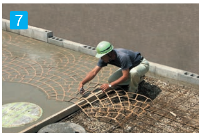
7 ステンシルの端部や不必要な部分をはさみ等で切り落 とします。
