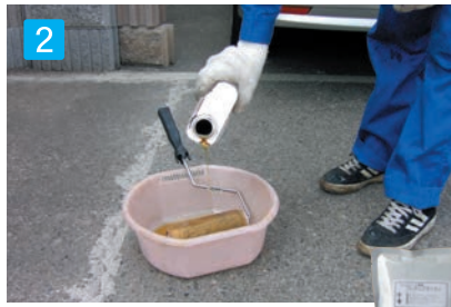
2 施工下地にプライマー(1液性)を塗布 塗布作業には、刷毛もしくはローラーを使います。 プライマー塗布可能面積の目安: ウーローラー 約150g/m 2 刷毛 約100g/m 2 (使用する塗付工具により異なります)
