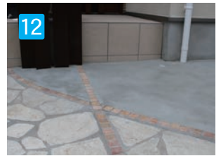
12 テープ養生をはがし、面取り不要で完成です。
