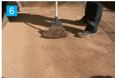
8 コテむらを無くすため、ほうきや刷毛等で表面を均して下さい。
