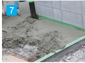
7 石をテープ養生し土間を打ちます。コテで均します。(土間は石の面より1~2mm程度下げます)
