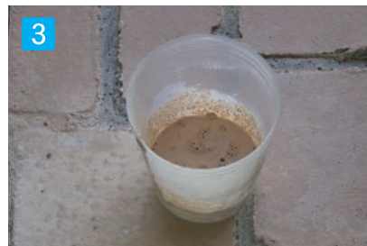
3 補修剤の準備 施工されているカラーと同じ種類のもので補修剤を作ります。 [使用材料] デックコートステンシル用パウダー デックコートステンシル用レジン 施工されている現状の色調に合うようにレジンを調合して下さい。 アートクリートステンシル用のハードナーは、接着剤の含有量が少なく、補修用に不向きなため使用しないで下さい。
