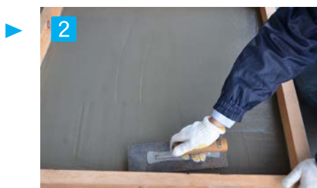
2 コンクリート打設
