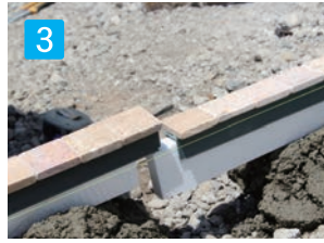
3 つなぎ施工の際はレールと土台をずらして (10cm以上推奨)ジョイントします。
