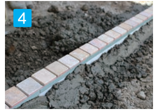
4 両側にモルタルで商品を固定します。 (目地無しタイプは施工工程の7に進みます。)
