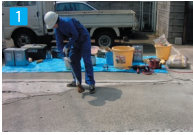
1 下地処理 施工現場の清掃
