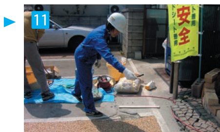
仕上げ作業 金ゴテ均し終了後、硬化する前に滑り止め(ノンスリップ材)を撒いて下さい。 ※ノンスリップ材を撒きすぎると、色むらの原因になりますのでご注意ください。
