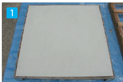
1 下地処理: 施工現場清掃作業。
