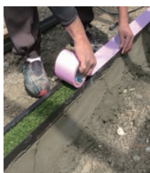
⑤養生テープの貼り付け
