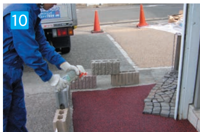
10 均し作業 養生する前に、霧吹きで水分を加えますと硬化速度が促進されます(外気温20℃以下の場合)。表面が濡れる程度にして下さい。加えすぎは施工不良の原因となります。
