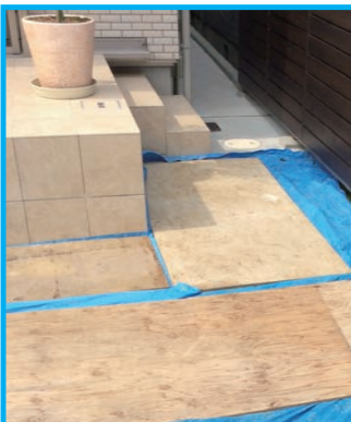
圧着・養生の様子
