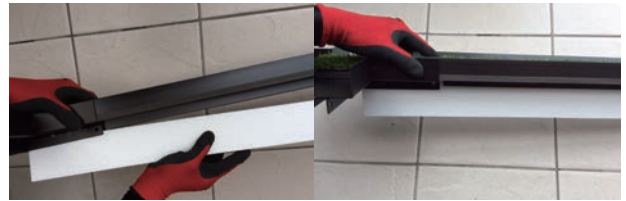
②ベース材をレールにはめ込み、固定します。
