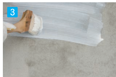
3 接着専用プライマーを刷毛で塗布して下さい。
