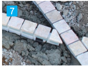
7 ストレートタイプとアールタイプが交差する箇所の施工はアールタイプの石部分を取り外し、角度を合わせ切り取って施工して下さい。
