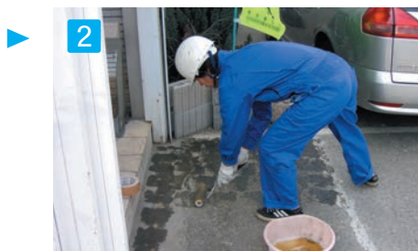
2 施工下地にプライマー(1液性)を塗布
