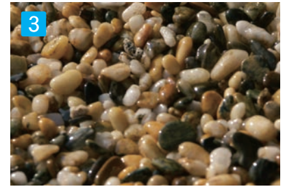
完成 硬化するまで養生して下さい。 (硬化までの目安 夏場: 6 時間以上 冬場: 2 4 時間以上)
