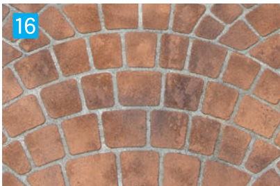
16 完成 ステンシルパターン/フィッシュスケールN ベースカラー/サンドストーンN アクセントカラー/オータムブラウンN
