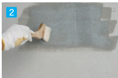
2 下地専用プライマーを刷毛で塗布して下さい。
