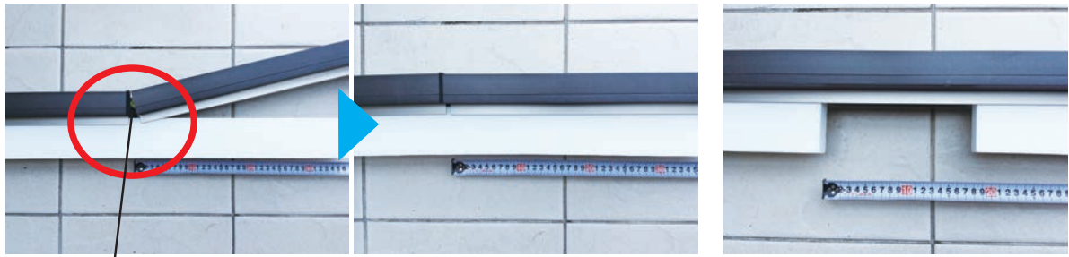
継目の緩衝材 (防水テープ) の貼り付け
