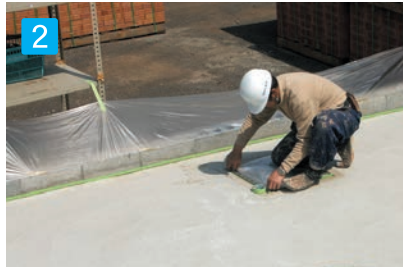
2 施工場所を養生
