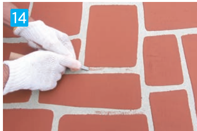
目地部に塗材が付着している場合は除去して下さい。上記の補修は白華防止剤を塗布してから行った方が除去しやすくなります。
