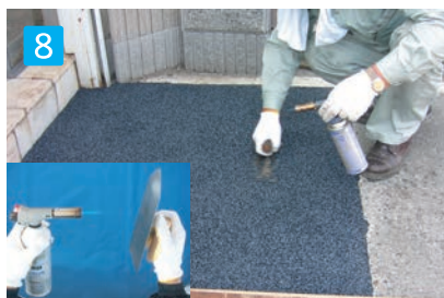
8 均し作業 仕上げは均コテを使用し、平滑になるように十分押さえながら同時に施工厚を確認して仕上げていきます。金コテに樹脂が付着しますので、バーナーで熱を加えると金コテの滑りが良くなります。
