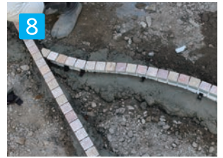
8 両側にモルタルを置き商品を固定します。
