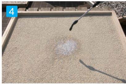
4 吹きつけ(写真は噴霧器) 樹脂を付属のスプレーや噴霧器(現地調達)で石の表面を洗い流すように均等に規定量を吹きつけて下さい。
