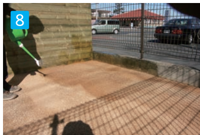
10 2次散水(目安時間1次散水後 夏場:約30分、冬場:約60分) 手で押さえて跡が残らない程度に硬化したら散水可能。ジョウロ(シャワーホース)を使って均一に散水して下さい。清水(水道水)を使用して下さい。(1㎡あたり15~18ℓ:季節や厚みにより変動あり)目安としては水が薄く浮き上がる程度に散水して下さい。散水量が不足すると下層部まで水が浸透しないため、硬化不良やクラックの発生原因になりますのでご注意ください。
