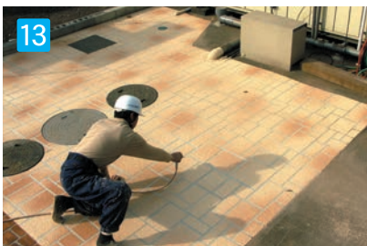
13 清掃 エアガン・フロアー等を使用して清掃。 ※乾燥期間: 夏場1時間、冬場(10℃)3~4時間。
