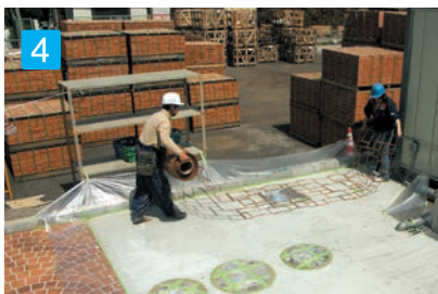
4 ステンシル(型紙)の設置 ステンシルの設置。ツヤのある方が上です。
