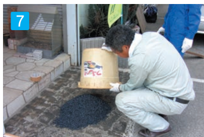
7 均し作業 合材を施工箇所へ移します。
