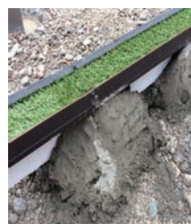
②モルタルを敷きベース材を固定し、水糸に合わせて勾配や傾きを調整する（水糸を2本張って天端を合わせることで、調整がしやすくなります）
