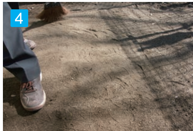
4 転圧。(踏み固める。) 端部はブロック等で固定し、境界部の抑えをしっかり行って下さい。
