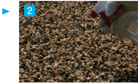
2 回目の噴霧 1 回目のスプレーの後、数分おいてから均等にスプレーして仕上げます。
