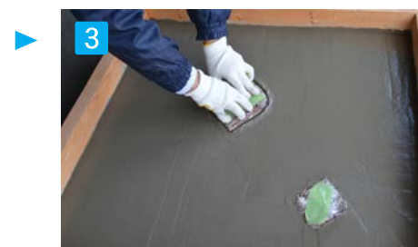
3 デザインピースを埋め込む ※コンクリートがまだ柔らかいうちに埋め込む(注意3)
