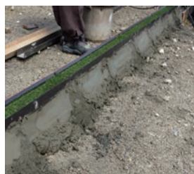
②モルタルを敷きベース材を固定し、水糸に合わせて勾配や傾きを調整する（水糸を2本張って天端を合わせることで、調整がしやすくなります）
