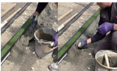
④ベース材へモルタルを擦り付け、固定する
