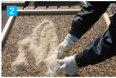
2 充填材の敷き均し 充填材(粉末)を適量配り刷毛やブラシで石目の間や隙間に充填しながら均一に敷き均して下さい。
