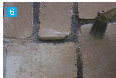
6 シーラー塗布 欠け部分の補修が完了したら、シーラーを塗布して下さい。
