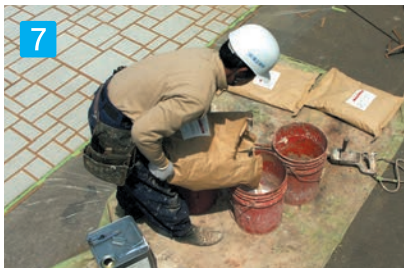
7 吹き付け用合材の作成 計量カップにて計量したレジンにパウダーを混入。混合割合はパウダー1袋に対しレジン4ℓを目安として下さい。
