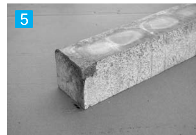
5 仕上げ 充填材の余分は引き取り仕上がり面を金コテを使って整える。
