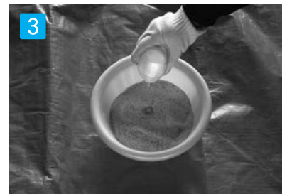
3 充填材と水を混ぜる 硬化が早いため使用する面積に合せて必要な分だけを計量して混ぜて下さい。(1kgあたり水110cc)
