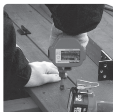
皿取りキリでテーバー 加工します。 ※床板の皿取り加工は、大きく 取りすぎないように注意して下さい。
