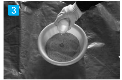
3 充填材と水を混ぜる 硬化が早いため使用する面積に合わせて必要な分だけを計量して混ぜて下さい。(1kgあたり水110cc)
