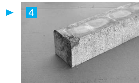
4 均し 充填材の硬化の進み具合を見ながら金コテを使って形を作っていく。
