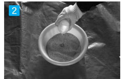
2 充填材と水を混ぜる 硬化が早いため使用する大きさに合わせて必要な分だけを計量して混ぜ合わせて下さい。 (1kgあたり水110cc)
