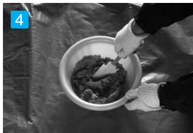
4 攪拌 硬化時間が夏場は最短で約5分(冬場の低温時でも約45分)と短いので速やかに施工して下さい。
