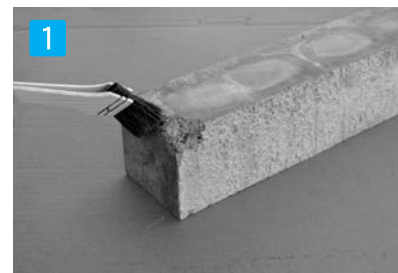
1 下地処理 施工部分の清掃 (ゴミ・塗料などをきれいに取り除いておく)
