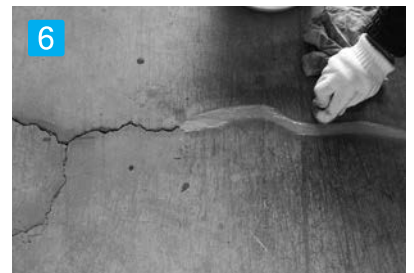
6 ふき取り 充填材が乾かないうちにウエス等で不要部分をふき取して下さい。
