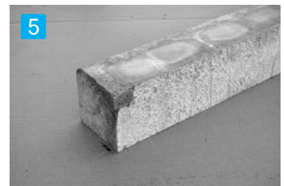
5 仕上げ 充填材の余分は引き取り仕上がり面を金コテを使って整える。
