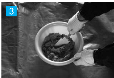
3 攪拌 硬化時間が夏場は最短で約5分(冬場の低温時でも約45分)と短いので速やかに施工して下さい。
