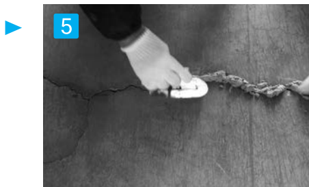
5 均し 金コテを使い充填材を埋め込むように均して下さい。
