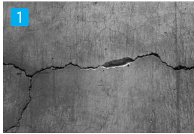
1 下地処理 施工現場の清掃(ゴミ、油、塗料などをきれいに取り除く)
