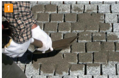
1 砂をブラシ・ホウキ等で目地仕上がりレベルー10mm(歩道仕様)まで目地に入れ込みます。
