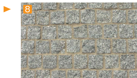
8 完成 硬化時間の目安: 施工後24時間
