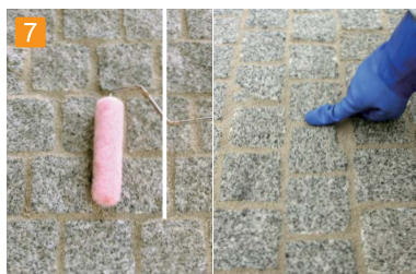
7 目地の仕上げ ・表面の平滑なものは、ローラーで押さええます。 ・表面に凹凸のあるものは、指で押さええます。
