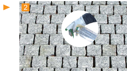
2 表面が濡れ色になるまで水を霧状に散布して下さい。合材が付着しにくくなります。
