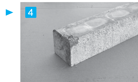
4 均し 充填材の硬化の進み具合を見ながら金コテを使って形を作っていく。
