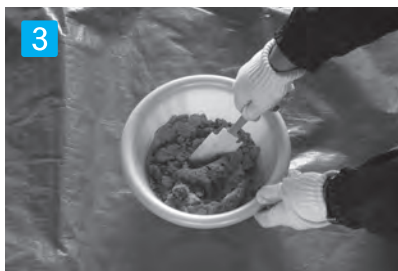
3 攪拌 硬化時間が夏場は最短で約5分(冬場の低温時でも約45分)と短いため速やかに施工して下さい。
