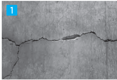
1 下地処理 施工現場の清掃(ゴミ、油、塗料などをきれいに取り除く)
