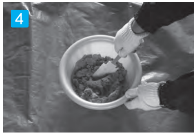
4 攪拌 硬化時間が夏場は最短で約5分(冬場の低温時でも約45分)と短いため速やかに施工して下さい。
