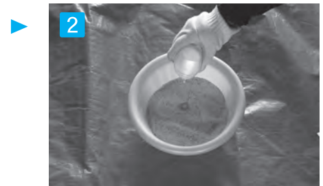
2 充填材と水を混ぜる 硬化が早いため使用する大きさに合わせて必要な分だけを計量して混ぜ合わせて下さい。 (1kgあたり水110cc)
