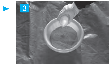
3 充填材と水を混ぜる 硬化が早いため使用する面積に合せて必要な分だけを計量して混ぜて下さい。(1kgあたり水110cc)
