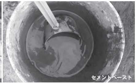
2 クイックストーン本体と空練モルタルとの接着を良くするために、クイックストーン裏面が密着する部分全体にセメントペーストを撒いて下さい。 セメントペーストの混合比・・・セメント(1):水(7)
