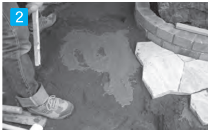
2 クイックストーン本体と空練モルタルとの接着を良くするために、クイックストーン裏面が密着する部分全体にセメントペーストを撒いて下さい。 セメントペーストの混合比・・・セメント(1):水(7)
