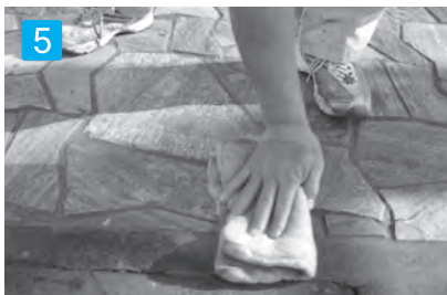
5 クイックストーン表面の目地モルタルが乾かないうちにスポンジで綺麗に拭き取って下さい。 * クイックストーン表面に残った目地用モルタルが硬化してしまうと除去できなくなるため注意して下さい。 * 綺麗に拭き取るためスポンジは、頻繁に水洗いして下さい。 * 冬場は作業可能な時間が短くなるため、目地施工の作業開始を午前中にするをお薦めします。
