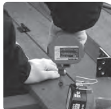
皿取りキリでテーパ加工します。 ※床板の皿取り加工は、大きく取りすぎないように注意して下さい。
