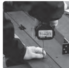
床板取付ビス(5×52)で固定。
