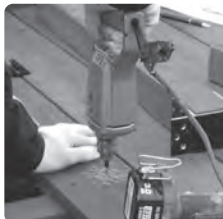
木工用ドリルで大引も共に下穴を開けます。
